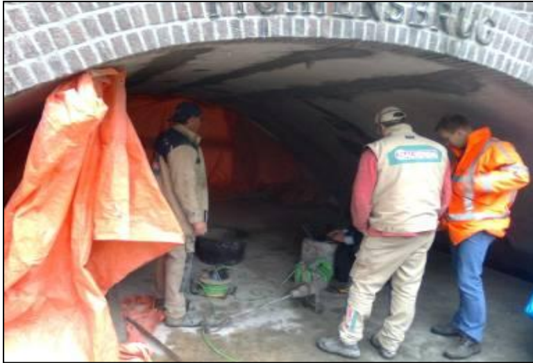
Figuur 16: Overzicht van de werkzaamheden op de eerste meetdag.
