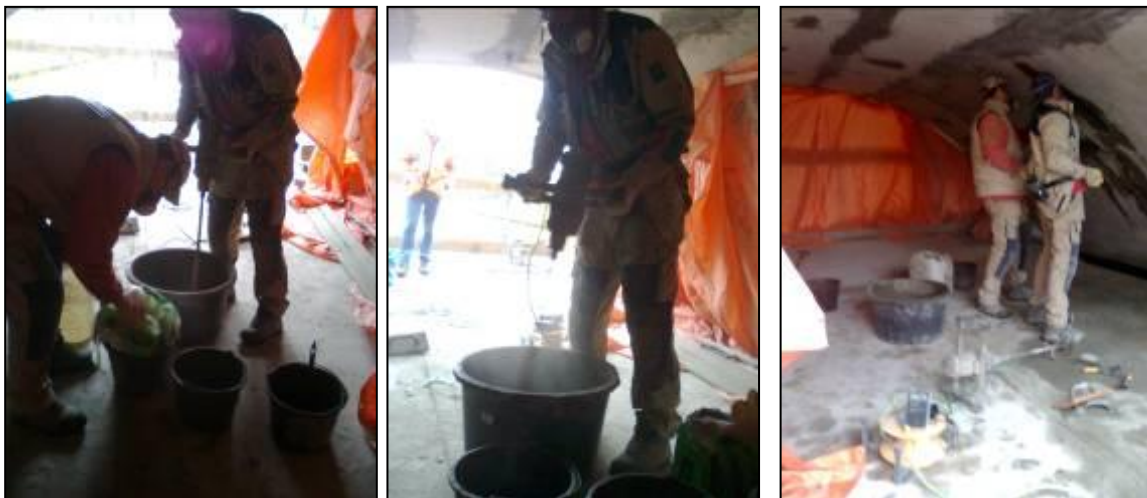
Figuur 15: Handmatig aanmaken en aanbrengen van NanoCrete R4 onder een brug.
