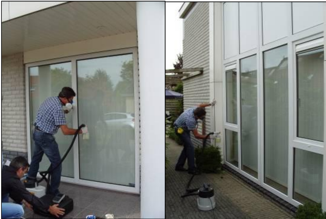
Figuur 9: Aanbrengen vuilafstotende coating op ramen van een woonhuis.
