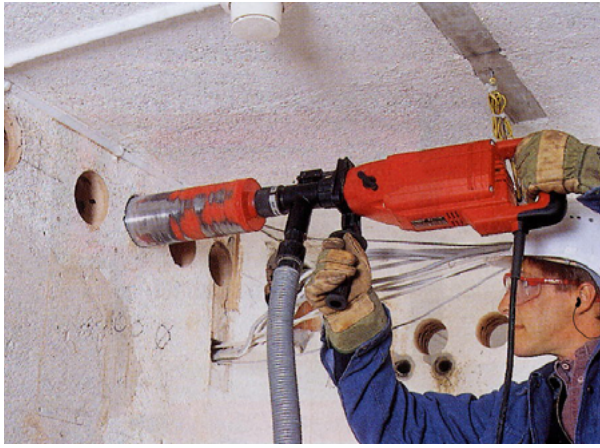
Een kroonboor kan met een afzuighulpstuk worden afgezogen.
