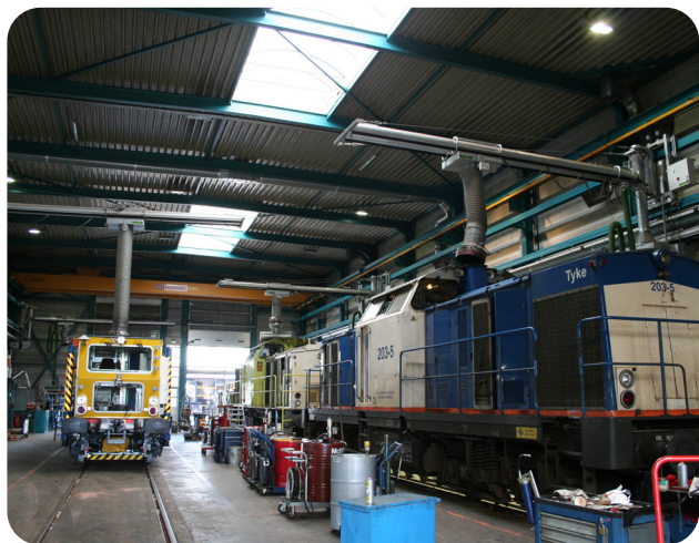
Figuur 5 - Puntafzuiging in een werkplaats.
