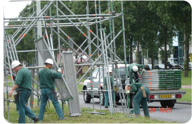
Steigermonteurs aan het werk (tillen)
