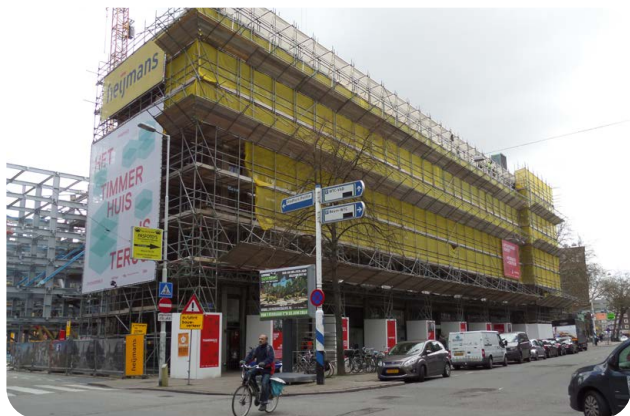
Steiger in gebruik
