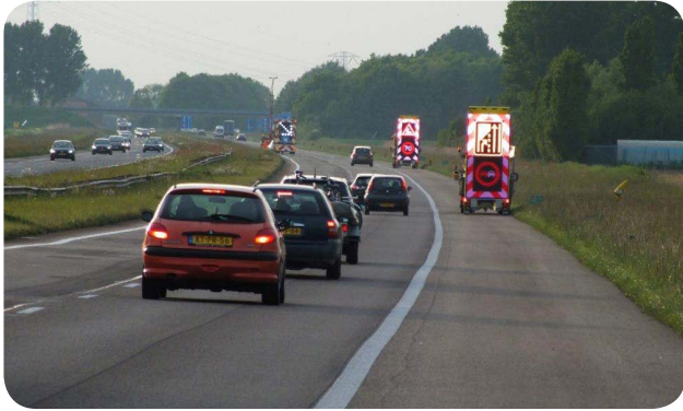
Werkzaamheden op autosnelwegen onder dekking van verkeerssignalering
