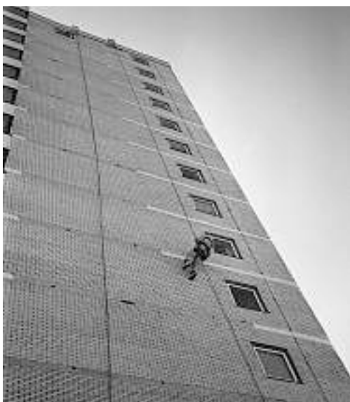
De inspectie van een buitengevel.
