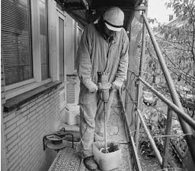
Het handmatig mengen met een mengijzer op een boortol.
