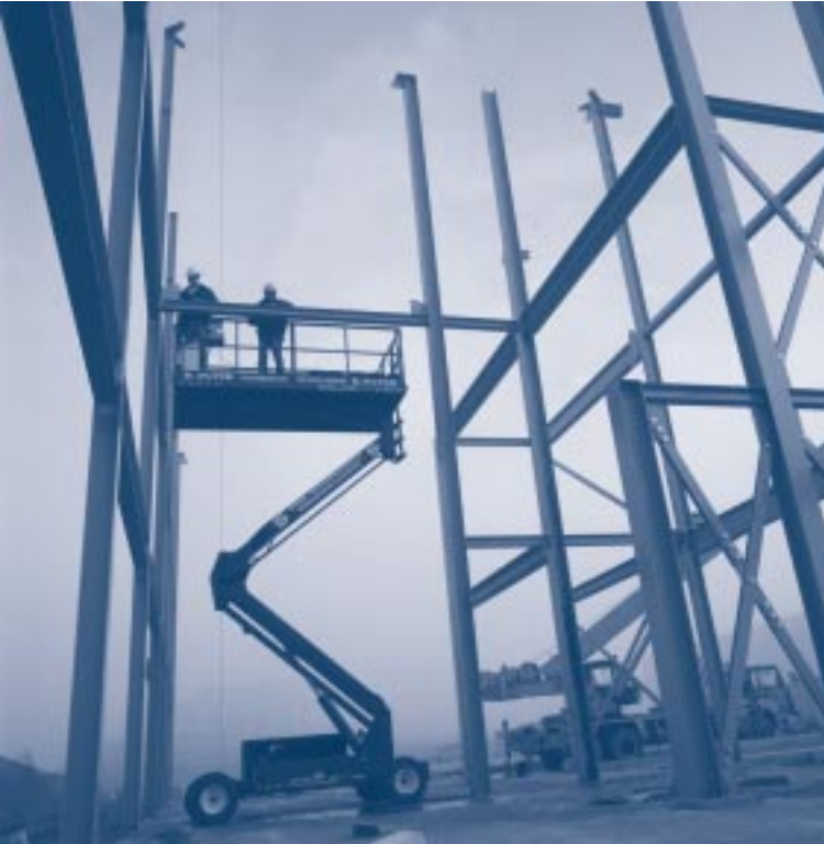
Montagewerkzaamheden vanuit een hoogwerker
