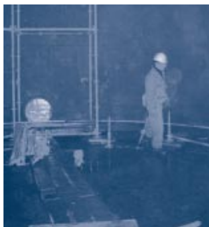
Werken in een tank
