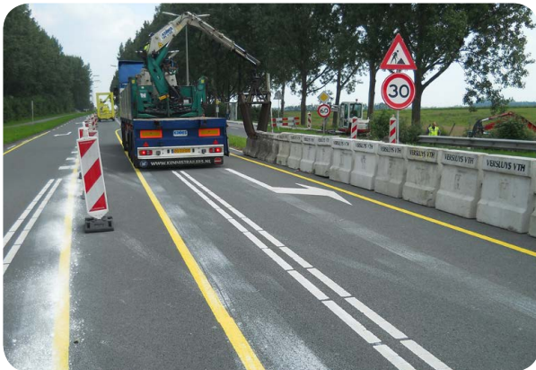
Afbouw wegafzetting op gebiedsontsluitingsweg
