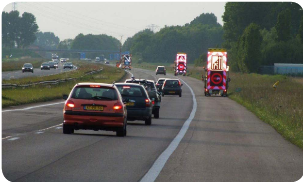
Werkzaamheden op autosnelwegen onder dekking van verkeerssignalering
