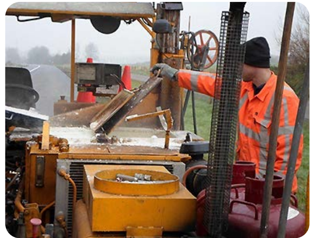
Afbeelding 2: vullen thermoplastketel met hete thermoplast.
