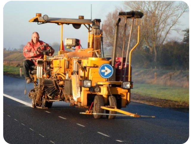
Afbeelding 1: machinaal aanbrengen van thermoplast.
