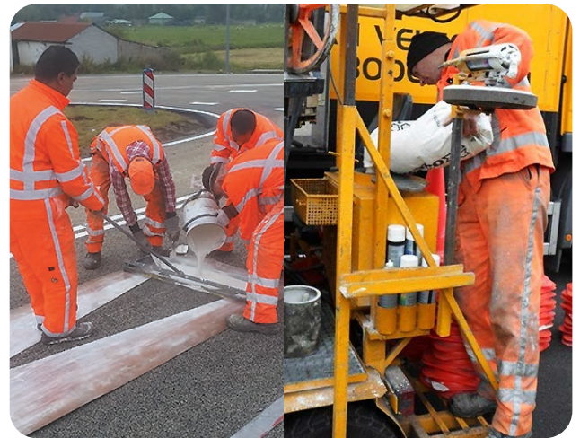
Afbeelding 3: fysieke belasting bij het handmatig aanbrengen van thermoplast (links) en het bijvullen van nastrooimiddel (rechts).
