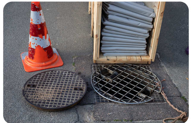
Figuur 4.2 RVS afdekking en tevens hulpmiddel
