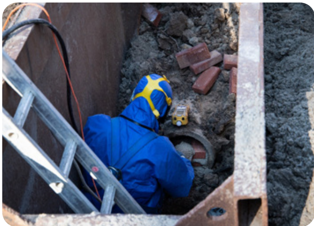
Figuur 4.1 Tijdens de werkzaamheden wordt doorlopend gemeten. In het geval van een calamiteit wordt deze werknemer m.b.v. een mobiele kraan uit de put gehesen. Let op de positie van de multimeter.
