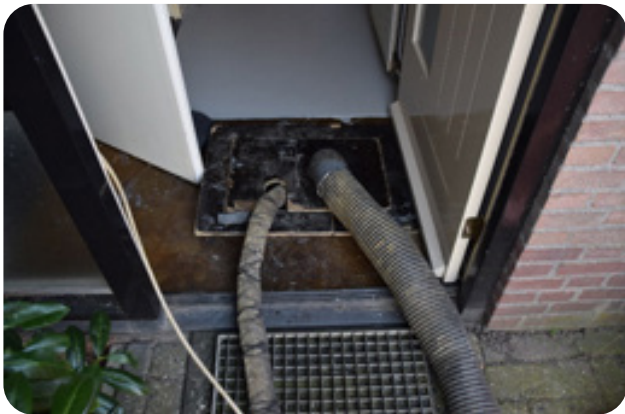
Figuur 4.3 Het afzuigen/ventileren van de kruipruimte tijdens het werk. Probeer bij deze werkzaamheden zo weinig mogelijk valse lucht aan te zuigen.
