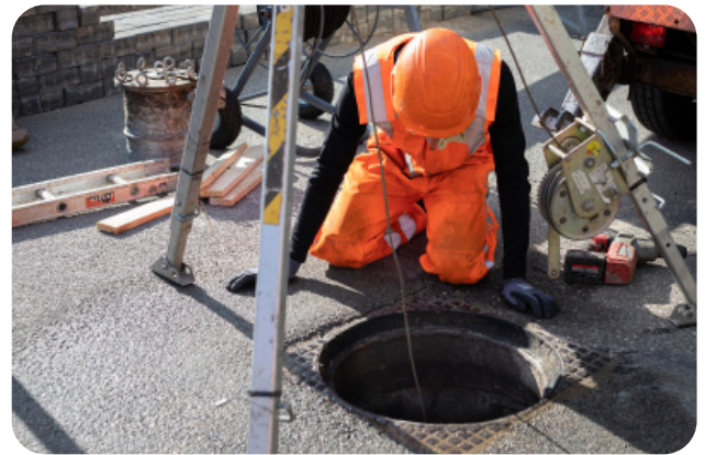
Figuur 4.1 De mangatwacht heeft zo mogelijk continue visueel contact
