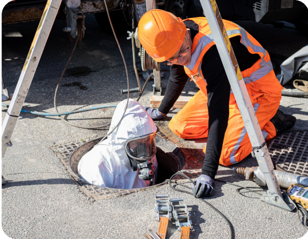
Figuur 3.3 Werken in een riool
