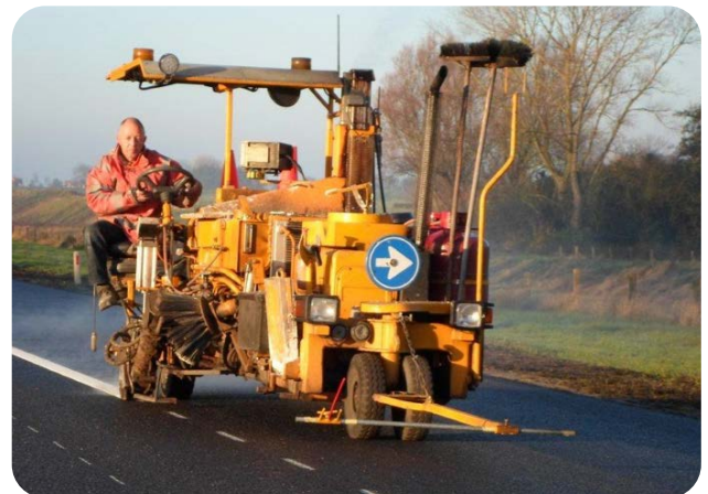
Afbeelding 1 - machinaal aanbrengen van thermoplast.
