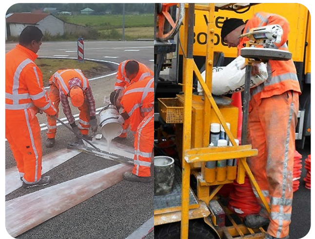
Afbeelding 3 - fysieke belasting bij het handmatig aanbrengen van thermoplast (links) en het bijvullen van nastroommiddel (rechts).
