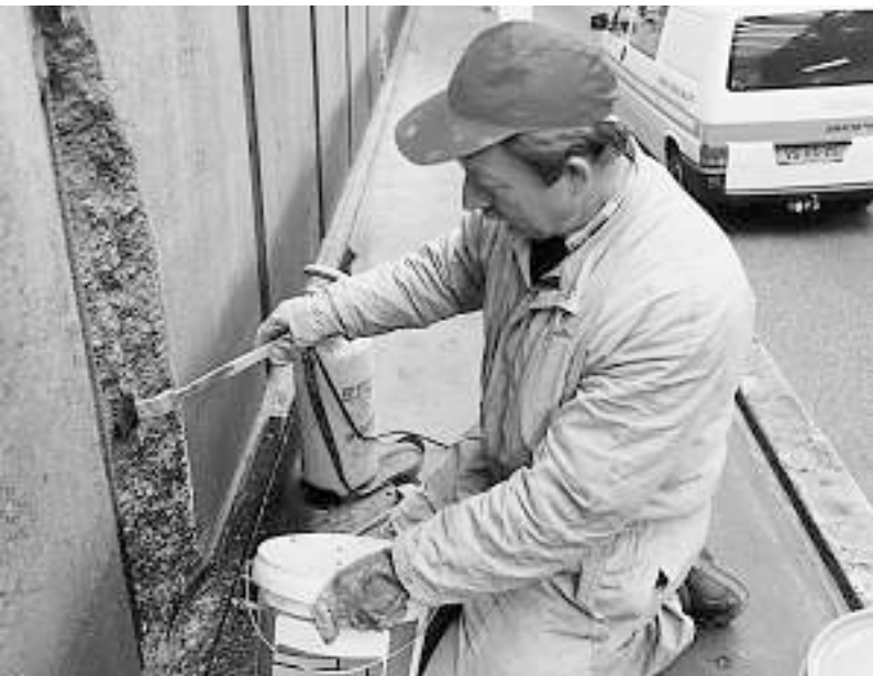
Een betonreparateur bezig met de voorbehandeling voor een reparatie met epoxygebonden betonreparatiemiddel.
