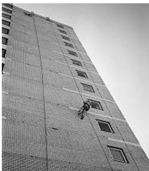
De inspectie van een buitengevel.
