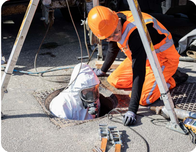
Figuur 3.3 - Werken in een riool
