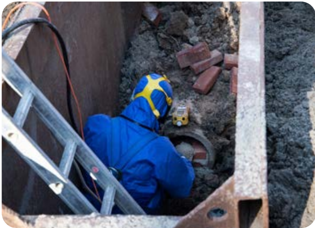
Figuur 4.1 - Tijdens de werkzaamheden wordt doorlopend gemeten. In het geval van een calamiteit wordt deze werknemer m.b.v. een mobiele kraan uit de put gehesen. Let op de positie van de multimeter.
