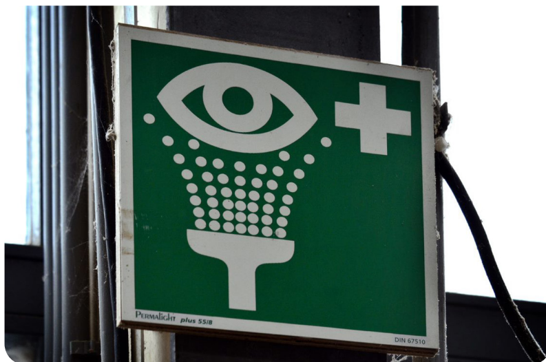
Afbeelding 3: Voorbeeld van een oogspoelfles (links). Op vaste werkplekken zoals werkplaatsen heeft een oogdouche de voorkeur. Deze moet goed vindbaar en bereikbaar zijn. Hiervoor worden borden met pictogrammen gebruikt (rechts).
