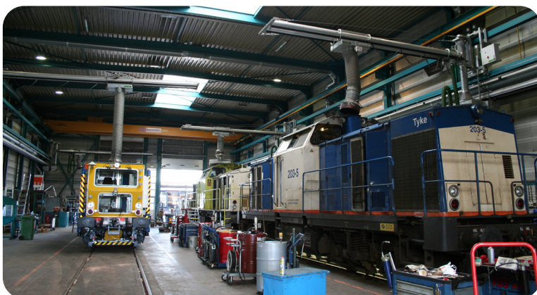
Figuur 6 | Puntafzuiging in een werkplaats
